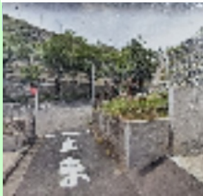
下：拡幅前の道路
